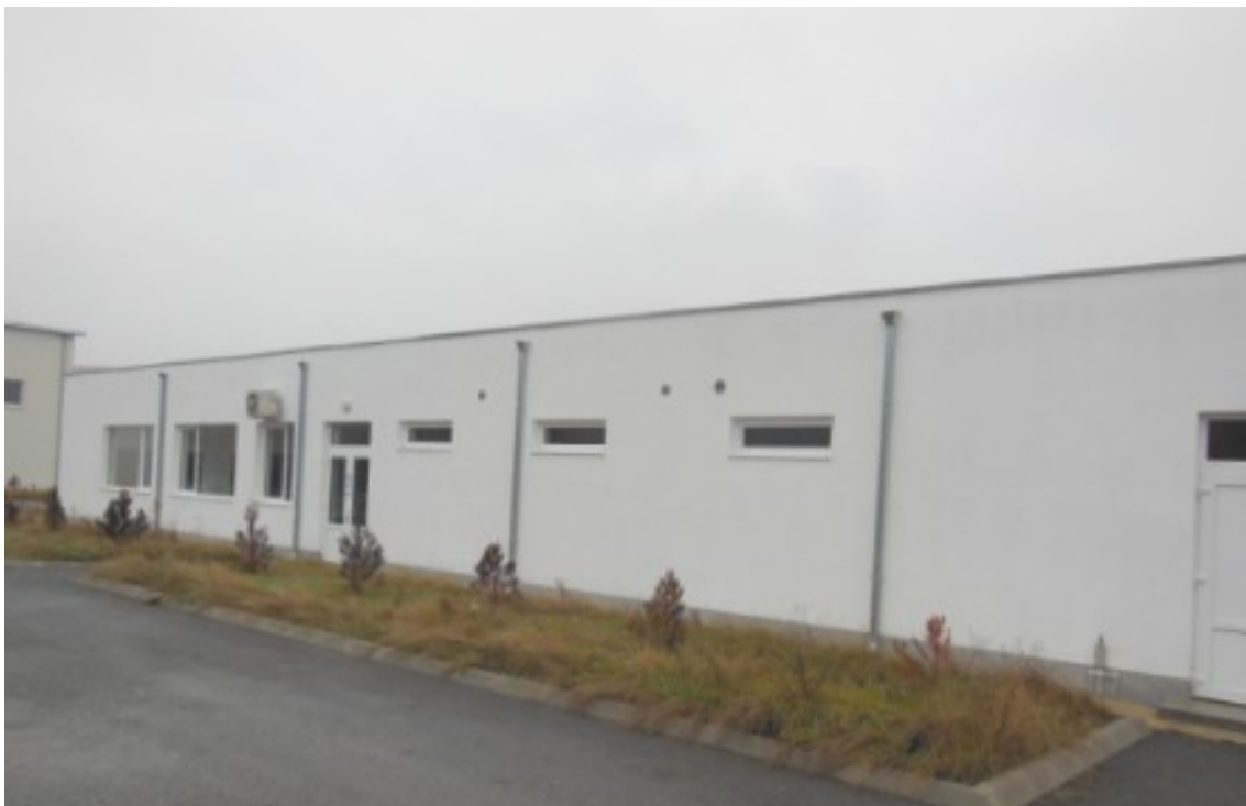
Zona administrativă a CMID Galda de Jos
