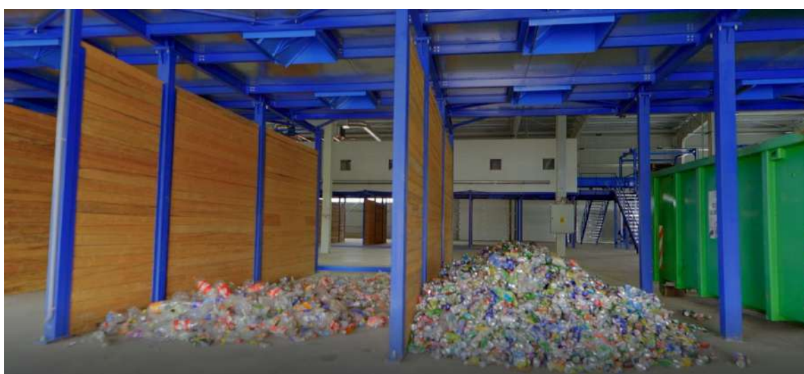
Fig. 2.6.1 - Centrul de Management Integrat al Deșeurilor de la Galda de Jos
