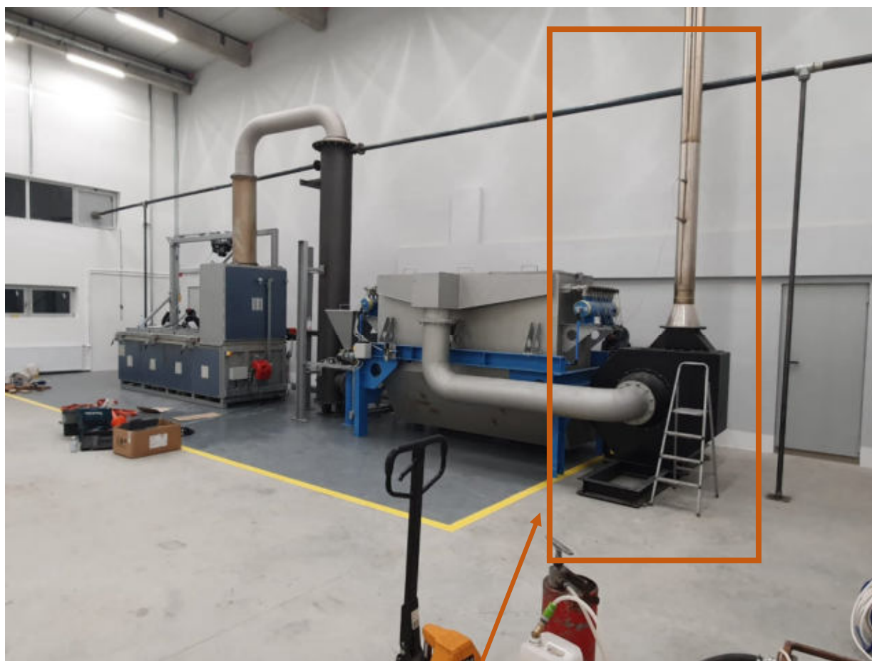
Figura nr. 14. exhaustor centrifugal
