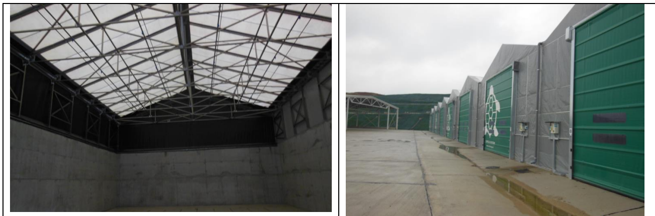
Biocelulele de tratare biologică
