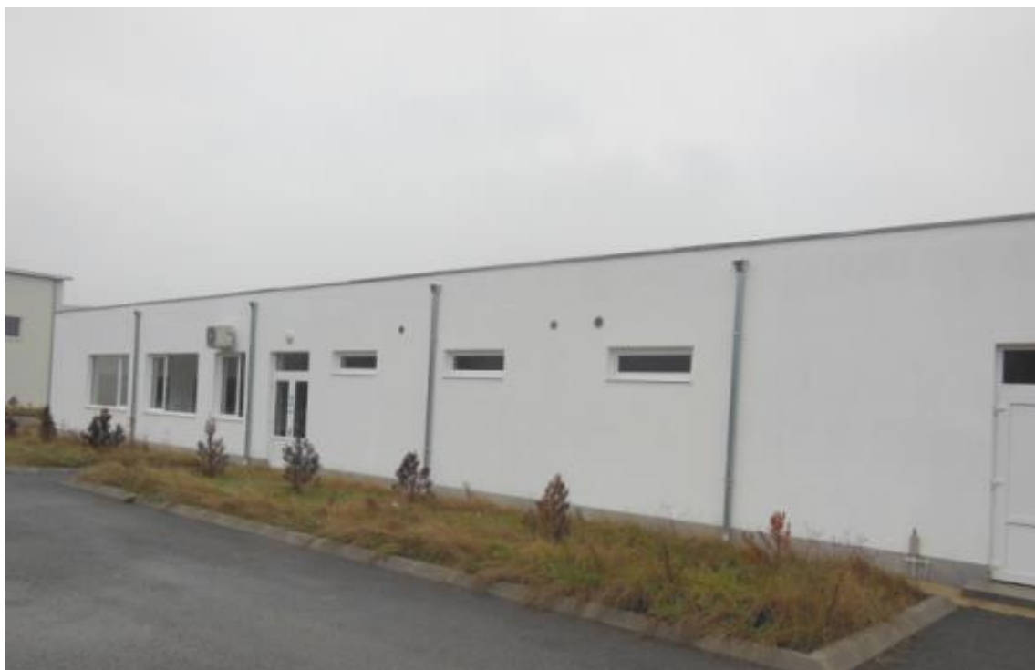
Zona administrativă a CMID Galda de Jos
