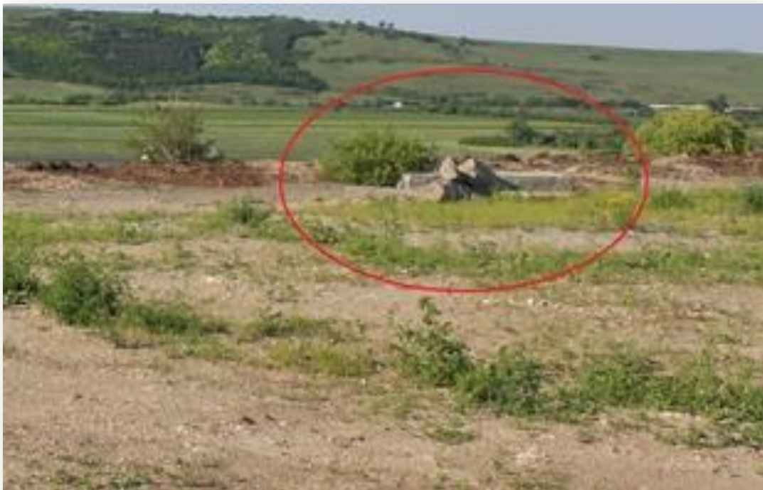
Fig. 4.2 Deșeuri de beton 17 01 01 –resturi de fundații pe care au fost montate unele dintre dotările amenajării de șantier.
