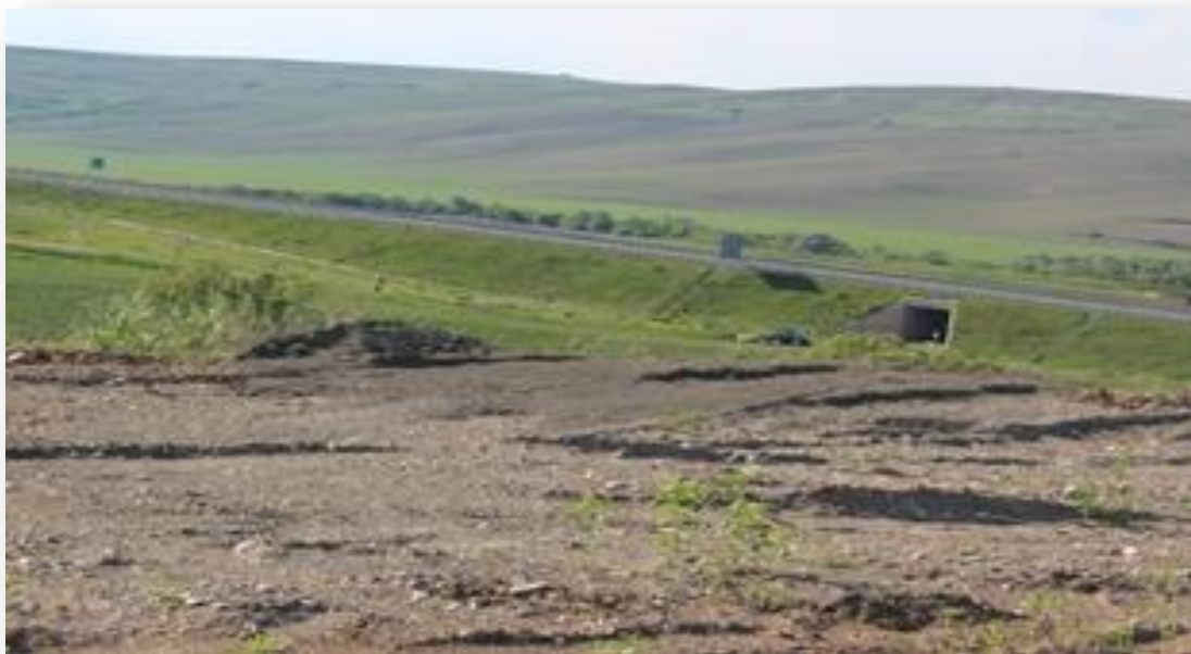
Fig. 4.1 . Platformele compactate ale amplasamentului sunt acoperite cu un strat de agregate mărunte și resturi fine de asfalt relativ ușoare ce pot fi preluate de apa pluvială.
