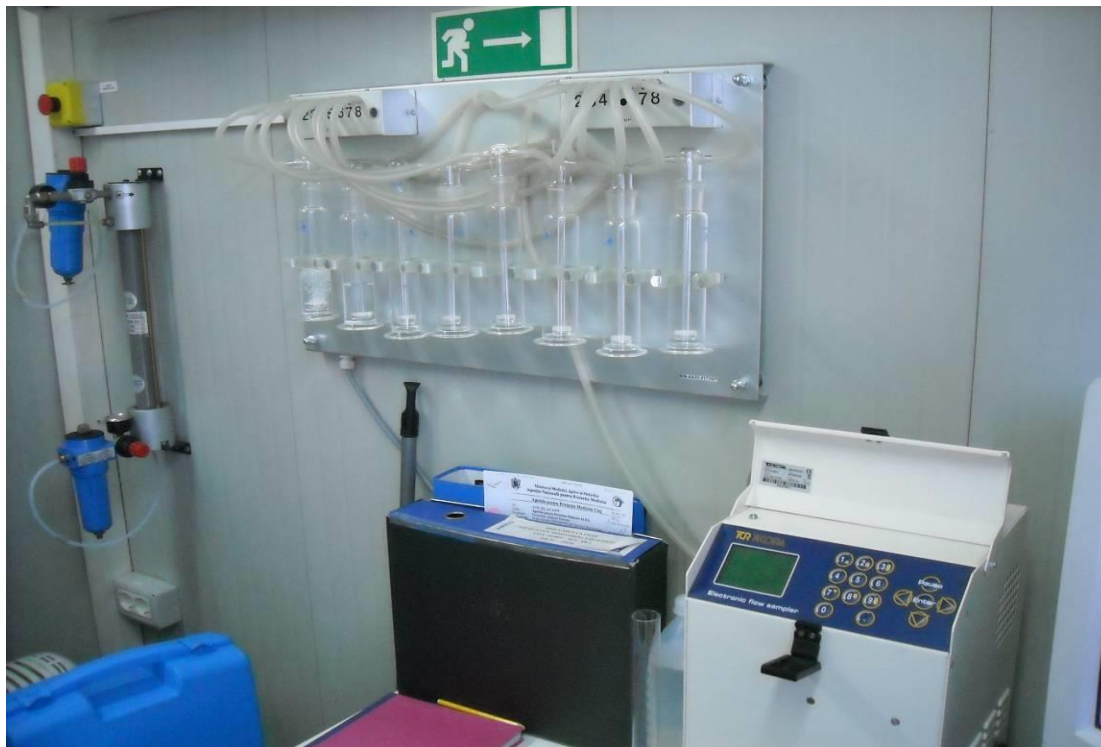
Figura nr. I.1.1.1.9 – Sistem de prelevare formaldehidă – AB2- Sebeș
